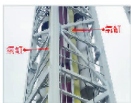
● 在軌道內有一個連接著上下兩條鋼索的吊索，而兩條鋼索亦緊扣著兩端的座橋升降台的上下位置。
